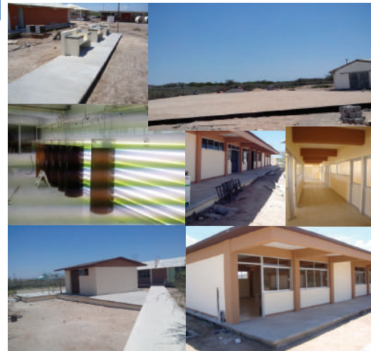
Rehabilitación de la Unidad Pichilingue.
